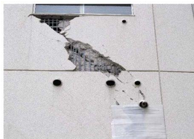
仙台市内RC造マンション
