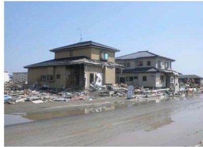
津波に耐えた新しい住宅
