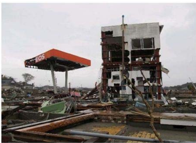
無惨な建物群(手前は、残った住宅基礎)
