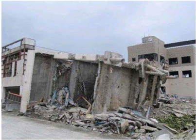
津波で転倒したRC建物
